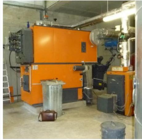
Abb. 25: Holz-Hackschnitzelkessel
